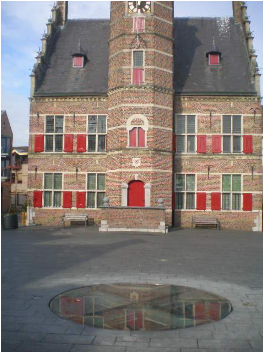
Verlichte en verwarmde afdekking waterput, markt Gennepe
